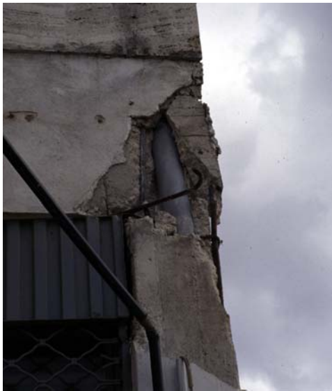
Φωτ. 23 (αρ.): Αστοχία κόμβου και απώλεια περίσφιγξης συνδετήρων λόγω τοποθέτησης υδρορροής εντός του υποστυλώματος Φωτ. 24 (δεξ.): Εμβολισμός υποστυλώματος από την πλάκα γειτονικού χαμηλότερου κτιρίου
