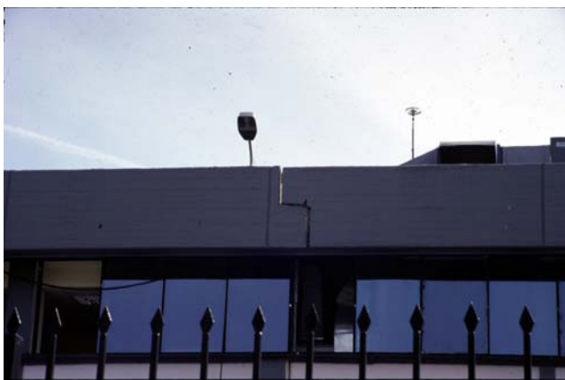
Φωτ. 25 (αρ.): Μικρό άνοιγμα αρμού διαστολής από οριζόντια σεισμική μετακίνηση σε κτίριο μεγάλης κάτοψης Φωτ. 26 (δεξ.): Στο ίδιο κτίριο, απώλεια στήριξης δοκού αρμού διαστολής λόγω μεγάλου ανοίγματος αρμού
