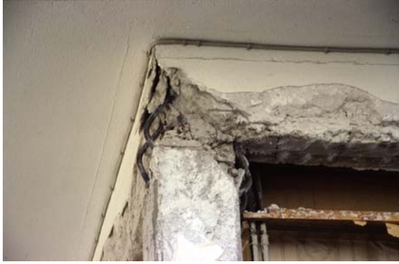
Φωτ. 21 (αρ.): Αστοχία εξωτερικού κόμβου με μείωση ακαμψίας του Φωτ. 22 (δεξ.): Αστοχία εξωτερικού κόμβου και πρακτική απώλεια στήριξης δοκού
