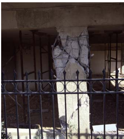
Φωτ. 6 (αρ.): Διατμητική αστοχία υποστυλώματος πάνω & κάτω με λυγισμό ράβδων και θραύση λεπτών & αραιών συνδετήρων Φωτ. 7,8 (μέσο & δεξ.): Διατμητική αστοχία υποστυλώματος με λυγισμό ράβδων και θραύση λεπτών & αραιών συνδετήρων
