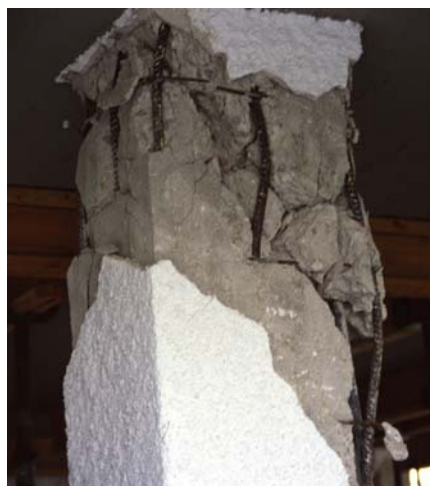
Φωτ. 6 (αρ.): Διατμητική αστοχία υποστυλώματος πάνω & κάτω με λυγισμό ράβδων και θραύση λεπτών & αραιών συνδετήρων Φωτ. 7,8 (μέσο & δεξ.): Διατμητική αστοχία υποστυλώματος με λυγισμό ράβδων και θραύση λεπτών & αραιών συνδετήρων
