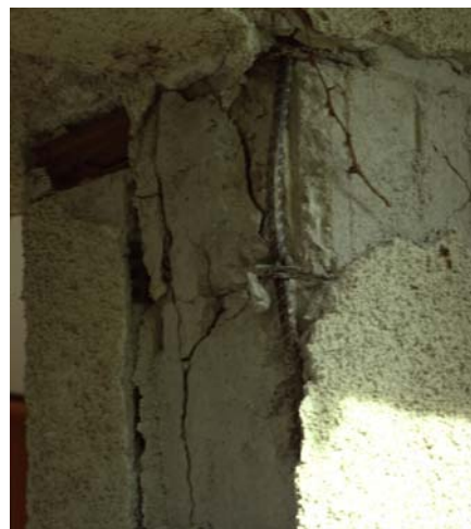
Φωτ. 12,13 (αρ. & μέσο): Άνοιγμα συνδετήρων με κάμψη άκρων κατά 90° μετά την αποφλοίωση της επικάλυψης των οπλισμών Φωτ. 14 (δεξ.): Εκτίναξη γωνίας διατομής σκυροδέματος λόγω μη συγκράτησης του κατακόρυφου οπλισμού στη γωνία συνδετήρα
