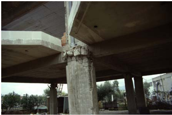
Φωτ. 10,11 (αρ. & δεξ.): Διατμητική αστοχία πάνω άκρου υποστυλωμάτων λόγω απουσίας συνδετήρων. Ο μανδύας συνδετήρων έφτανε μέχρι 0.50 m κάτω από τις δοκούς
